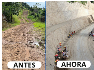
Construcción de caminos
