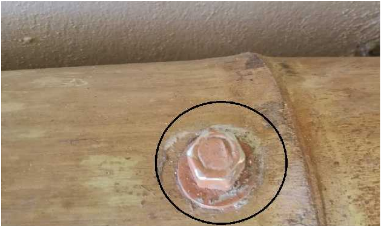
Imagen 8. Salón Comunal-tornillos pintados y sin corrosión
