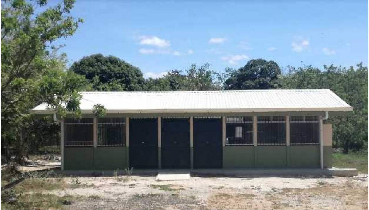
Salón multiusos - exterior
